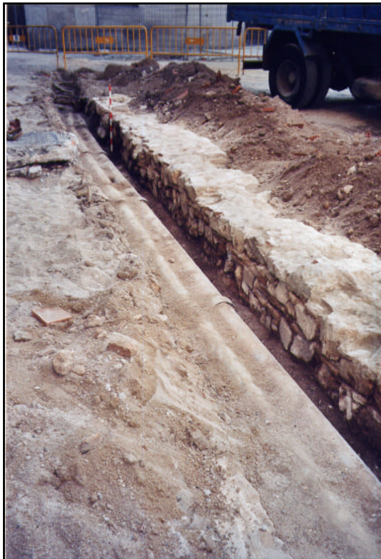
F. 28. Vista parcial del perfil sud-oest del mur de façana U.E 75, un cop realitzada la RASA 8. Al costat s'hi observen dues canalitzacions en servei.
