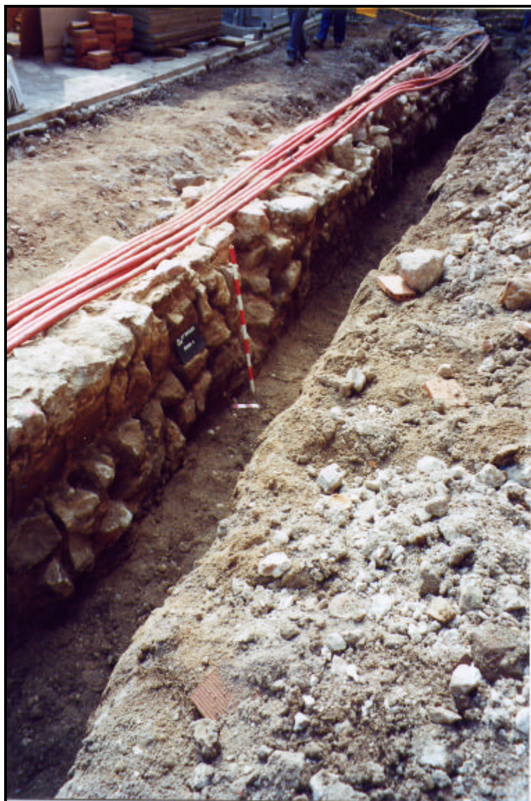
F. 25. Excavació de la RASA 9 situada en el carrer Pas de l'Ensenyança. En el perfil nord-est s'hi observa l'alçat de la fonamentació de l'antiga línia de façanes U.E 74.
