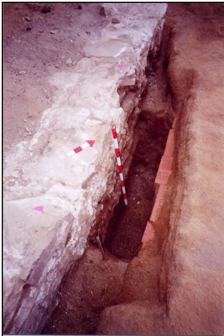
F. 13. Sondeig efectuat per col·locar un dels imbornals del carrer Gegants. S'hi observa la profunditat de la fonamentació del mur de façana U.E 49.
