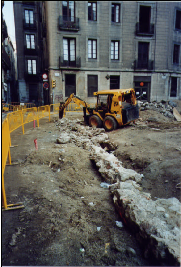
F. 26. Detall del procés de desmuntatge, sota control arqueològic, d'algunes estructures afectades per l'obra.
