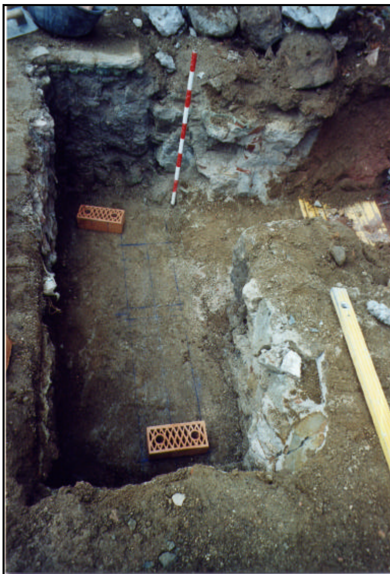
F. 23. Sondeig efectuat per tal d'instal·lar un dels imbornals situats en l'eix del carrer Gegants. S'hi observa com es va haver de rebaixar part de la fonamentació del mur de façana U.E 51.
