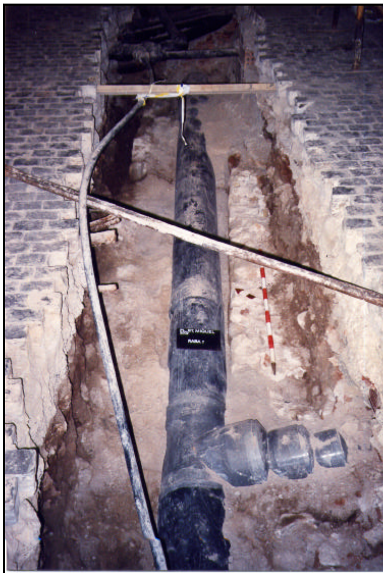
F. 39. Vista longitudinal de la RASA 7 efectuada a l'interior de l'Ajuntament. S'hi observa la canalització que s'havia de substituir i part dels murs laterals d'una claveguera moderna (U.E 16) situada just per sota.
